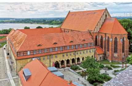
Blick auf das Dominikanerkloster Prenzlau
