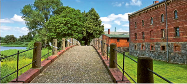
Blick auf Speicher und Haussee, Wolfshagen
